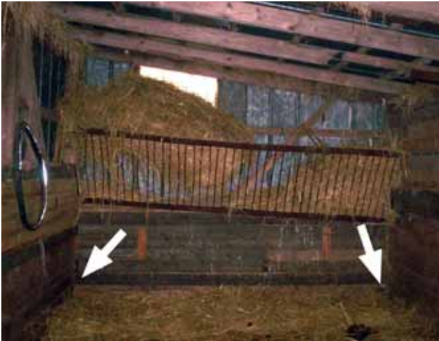
Abb. 1: Pferdehütte Pfeile zeigen auf die Rattenlöcher
