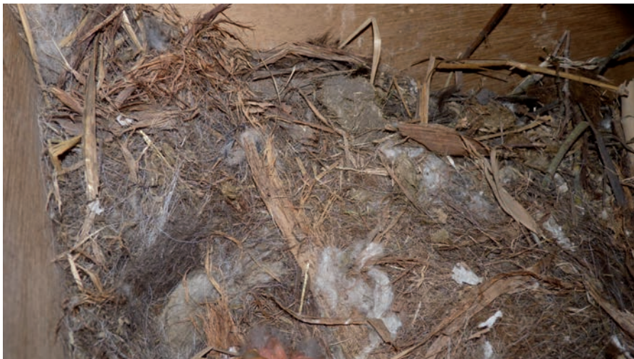
Bild 2: Dohleennest im Vorraum, links erhöht der versperrte Durchgang
