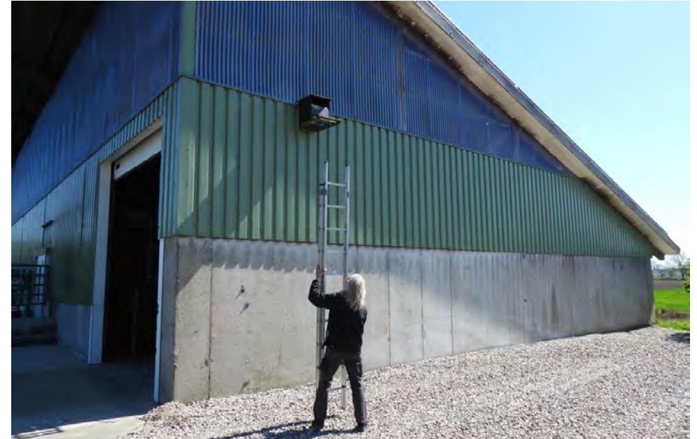
Abbildung 7: Hans-Georg Kaatz unter einer Turmfalkennisthilfe an einer Fassade. Foto: Matthias Haupt
